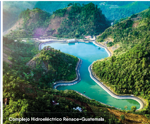
Complejo Hidroeléctrico Renace-Guatemala
